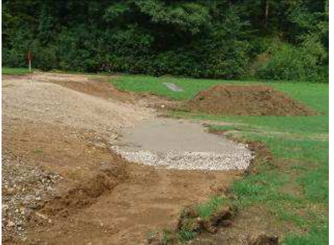
Der Überlauf der Quellfassung, die Vernässungszone und der Bau des Versickerungsbereichs.
