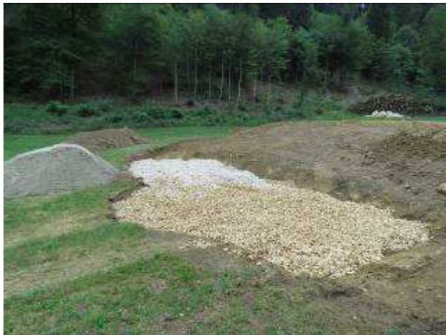
Der Überlauf der Quellfassung, die Vernässungszone und der Bau des Versickerungsbereichs.
