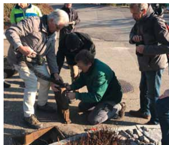
Auf ihren jährlichen Wanderzügen landen die Amphibien oftmals in Strassenschächten, aus denen sie sich nicht mehr befreien können. Als Hilfe gibt es jetzt wartungsfreundliche und kostengünstige Böschungsmatten, die in die Dolen gehängt werden. Pro Natura BL bietet interessierten Gemeinden und Privatpersonen auf Wunsch Demonstrationen zur Montage an.
