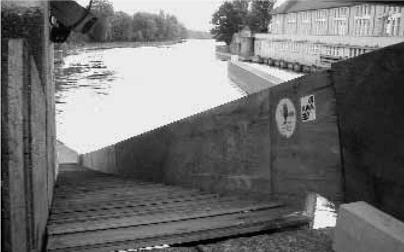
Dank dieser Holzrampe soll der Biber das Kraftwerk Augst überwinden. Aber weitere Massnahmen sind notwendig, um die Flüsse der Region bibergängig zu machen. (Foto: Kraftwerk Augst AG)
