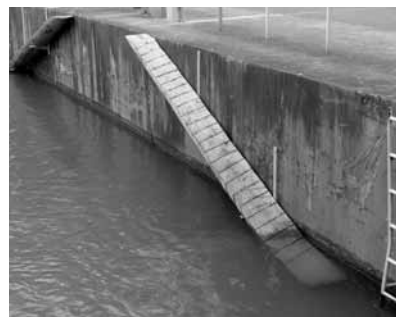
Neue Biberrampe beim Kraftwerk Birsfelden (Foto: Werner Götz)
