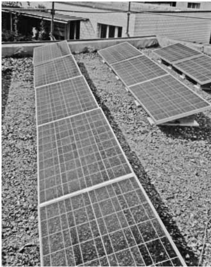
Erneuerbare Energie ist für Pro Natura Baselland seit längerem ein Thema. Seit 8 Jahren besitzen wir zusammen mit der Sektion Basel-Stadt auf dem Dach der Davidsboden-Überbauung in Basel eine Solarstromanlage. Die Anlage speist jährlich über 20'000 kWh in das Netz der IWB.
