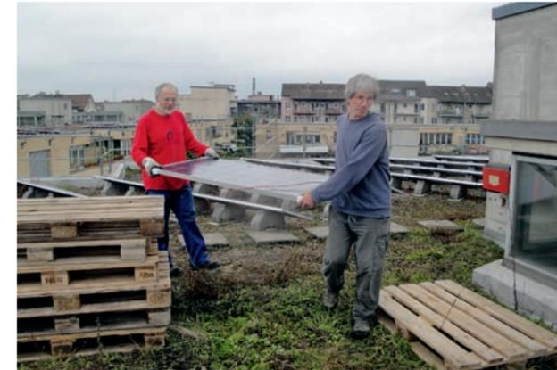
Da das Dach der Überbauung Davidsboden in Basel saniert werden muss, musste im Herbst die Pro Natura-Solaranlage leider demontiert werden. Sie wird diesen Winter wieder installiert und wird hoffentlich noch viele Jahre sauberen Solarstrom produzieren.
