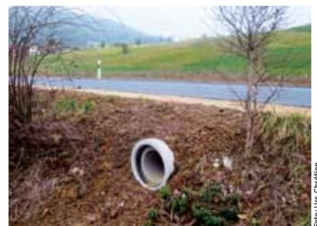
Eine Röhre, wie sie hier im Rahmen des Vernetzungsprojekts Rothenfluh des NUVRA erstellt wurde, kann Amphibien und Kleinsäugetern wie Wiesel das Queren der Strassen erleichtern.
