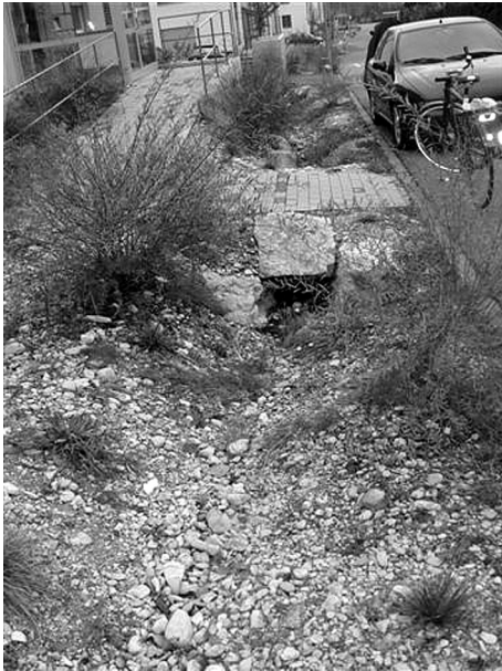
Abb. 2 Therwil realisierte konsequent bei der Generellen Entwässerungsplanung eine offene Gerinneführung für nicht-kontaminiertes Meteorwasser und leistet damit einen Beitrag zur ökologischen Vernetzung innerhalb des Siedlungsgebiets. Foto: Archiv D. Niederhauser
