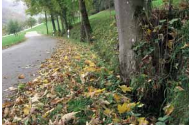
Abb. 60: Auch unauffällige Strukturen wie dieser Strassengraben in Reigoldswil gehören in ein Detailinventar.
