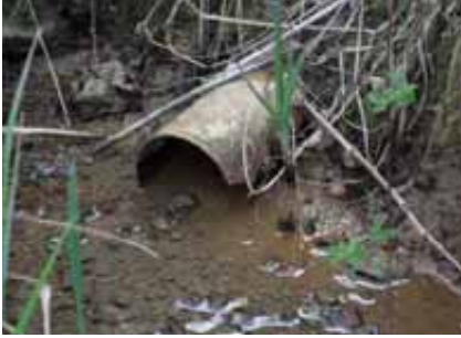
Abb. 46: Viele Drainagen sind über 60 Jahre alt und müssen saniert werden – Rückstau führt zur Zerstörung der Entwässerungssysteme.
