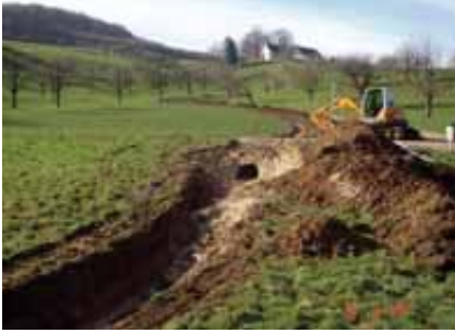
Abb. 78: Im Winter 2006/2007 wurde der Mädersrütibach auf einer Länge von 200 m durch die Einwohnergemeinde Pratteln ausgedolt. Das Land wurde von der Bürgergemeinde zur Verfügung gestellt. Die Gesamtkosten beliefen sich auf Fr. 20'000 (Fr. 100/Laufmeter). Die Kosten wurden von der Einwohner- und der Bürgergemeinde Pratteln sowie Stiftungen getragen (Foto: Carlo Pirozzi).
