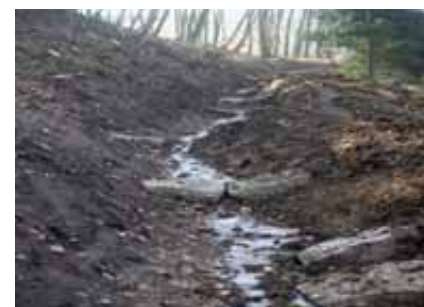
Abb. 79: Im Winter 2008 wurde der Heulenlochbach auf einer Länge von 210 m ausgedolt. Die Kosten beliefen sich auf rund 20'000 Franken (Fr. 95/Laufmeter). Hinzu kommen jährliche Pflegekosten von 2000 Franken (Foto: Carlo Pirozzi).
