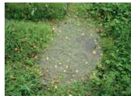
Abb. 31: Gelegenheit Vernässung: defekte Drainage in Brislach.
