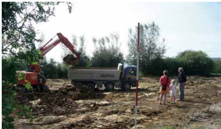
Abb. 68: Während den Bauarbeiten muss die Projektleitung regelmässig anwesend sein. Ausserdem ist die Information der Bevölkerung wichtig (Foto: Werner Götz).
