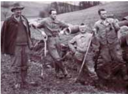
Abb. 80: Die Eindolung des Hintereggbächlis im Rahmen der Anbauschlacht zur Zeit des zweiten Weltkriegs war aus der damaligen Sicht sinnvoll und notwendig (Foto: Archiv Max Wirz).
