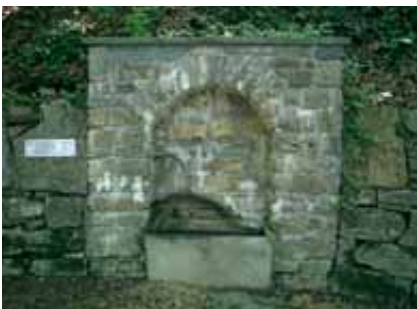
Abb. 10: Trinkwasserbrunnen am Wisenberg (Häfelfingen).
