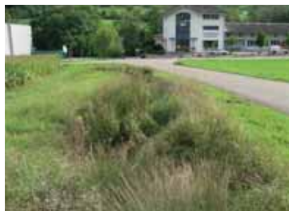
Abb. 35: Gelegenheit Erschliessungsstrasse: neuer Graben in Thürnen.
